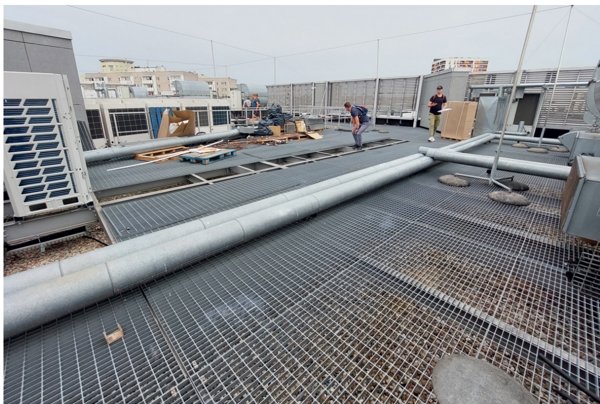
Rys. 1 Stalowy pomost zbiorczy nad dachem budynku D – widok ogólny
