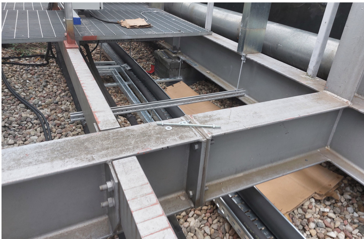
Rys. 2 Stalowy pomost zbiorczy nad dachem budynku D – detale połączeń
